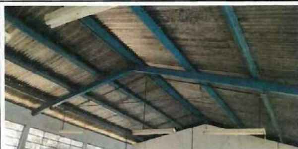
Foto 5: Mantenimientos de la estructura de soporte de metal
