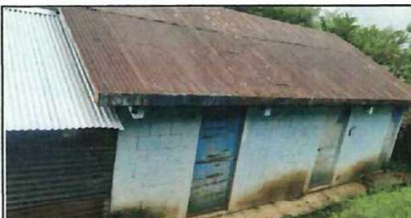
Foto 4: Sustitucion de puertas de metal y mantenimientos
