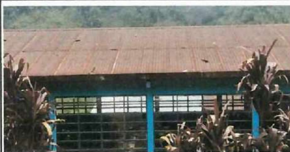
Foto 2: Sustitucion de las laminas acanales por troqueladas
