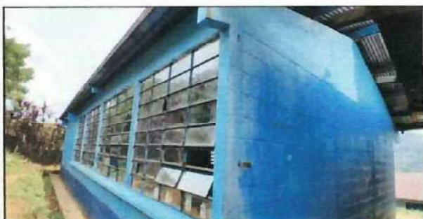
Foto 3: Mantenimiento del soporte de las ventanales
