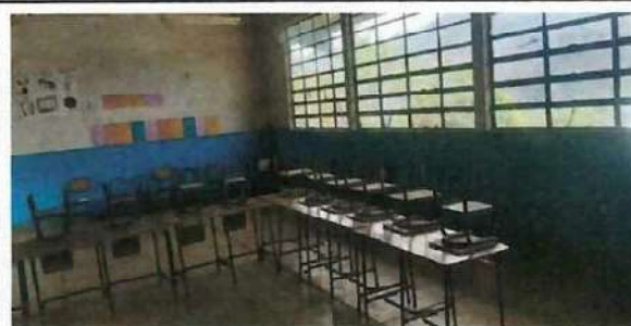
Foto 6: Sustitucion de vidrios quebradas en una aula y de la Direccion
